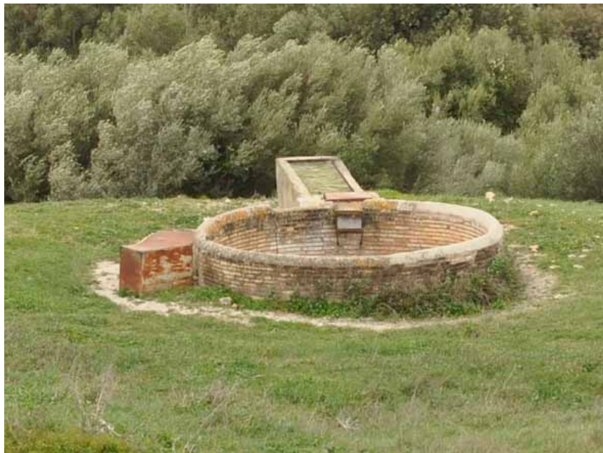
Pozo del Taramal (M. Limón Andamoyo, marzo 2015)
