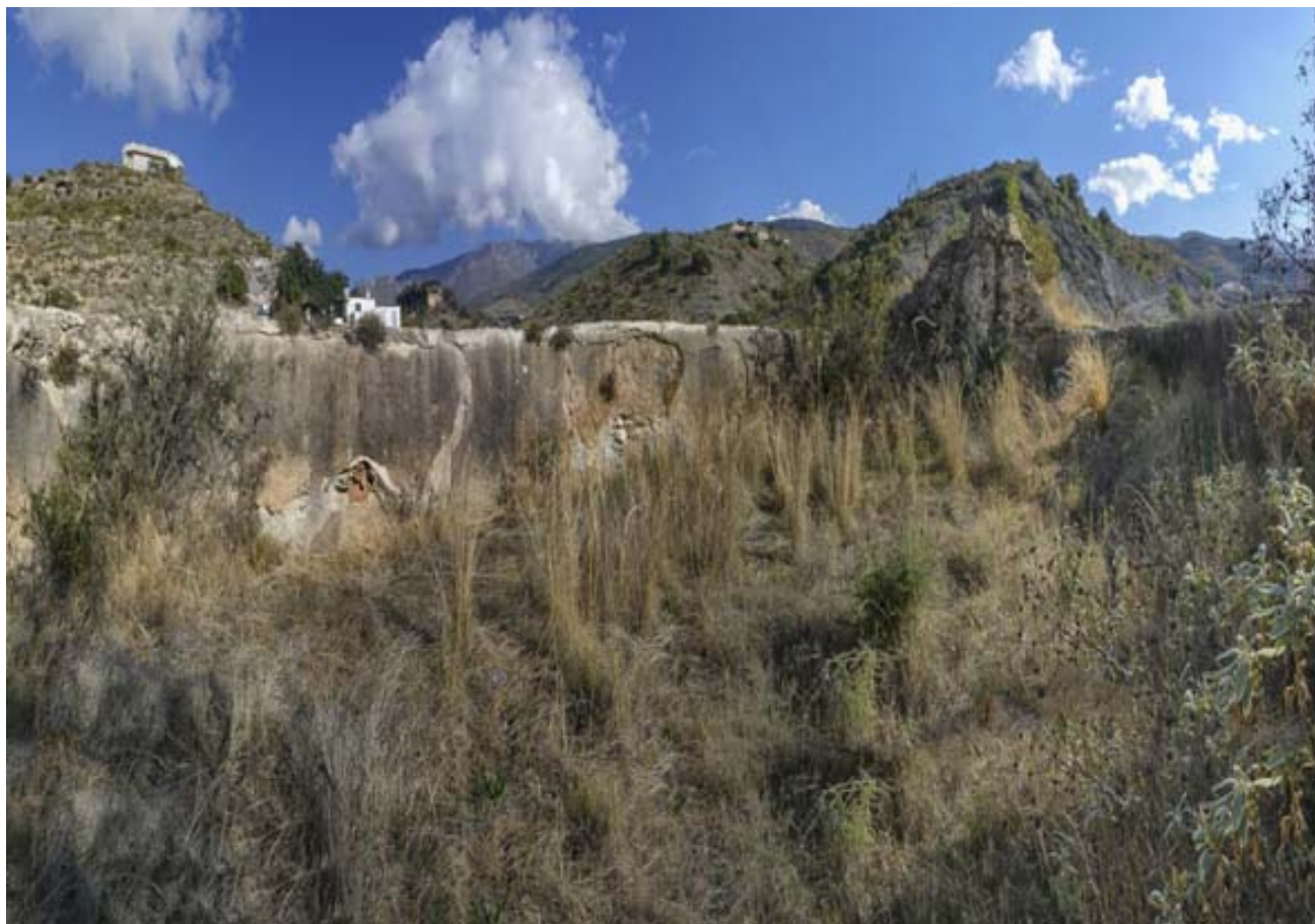
Molino de Los Tablones, vista general (J. Rubia González, noviembre 2020)
