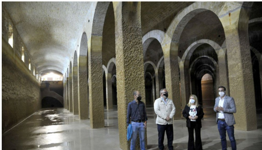
Interior del depósito
