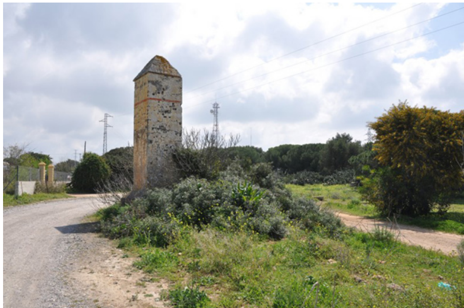
Torrecilla del Acueducto (M. Limón Andamoyo, marzo 2016)
