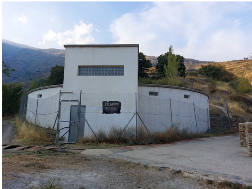
Depósito de abastecimiento (M.Limón Andamoyo, octubre 2021)
