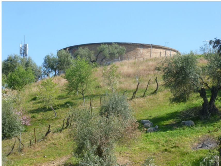
Depósito distribuidor de Las Cruces (R. Velasco Riejos, marzo 2022)
