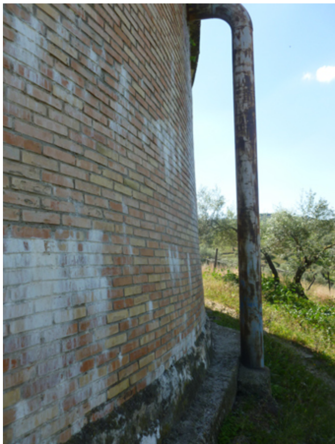
Vaciado del agua de los manantiales Aliseda y Banduro (R. Velasco Riejos, marzo 2022)
