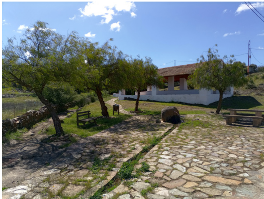
Vista general del complejo. La fuente y su desagüe frente al lavadero y a la izquierda de éste el pozo (J. F. Martín Álvarez, abril 2022)
