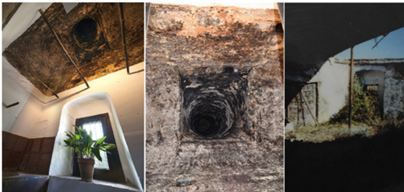
Chimenea del Caserío Los Pozos de la Nieve, detalle (centro, A. Márquez Pascual, mayo 2022) y antiguo postigo del matadero previo a la restauración del patio (Imagen cedida por D. Winderickx)
