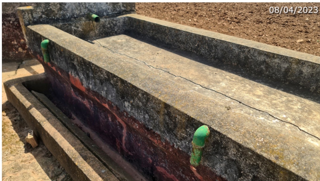
Abrevadero inferior alimentado con los rebosaderos del pilar (A. Ventas, abril 2023)
