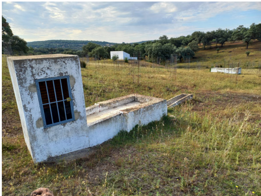
Pozo y pilares- abrevaderos (R. Velasco Riejos, mayo 2023)
