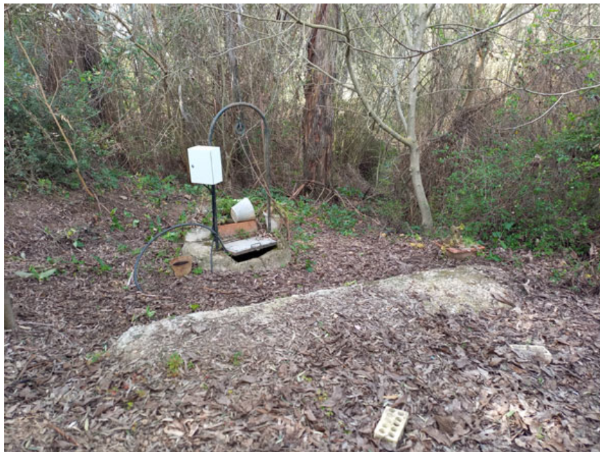
Acercamiento al pozo en la margen izquierda del arroyo (R. Velasco Riejos, abril 2023)
