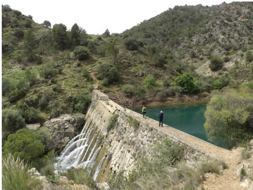
Dique del Nacimiento (M. Limón Andamoyo, marzo 2024)
