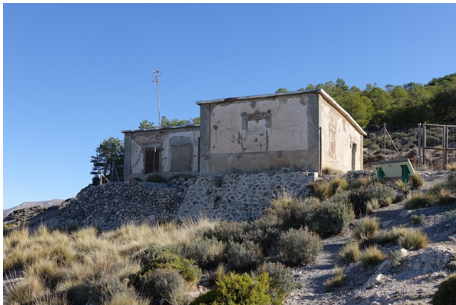
Casilla del Agua (M. Limón Andamoyo, noviembre 2023)
