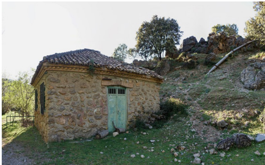
Toma de agua del Canal de la Espartera (M. Limón Andamoyo, mayo 2024)
