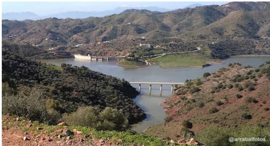
Presa de Embalse de Casasola ( www.pueblosdemalaga.com , enero 2020)
