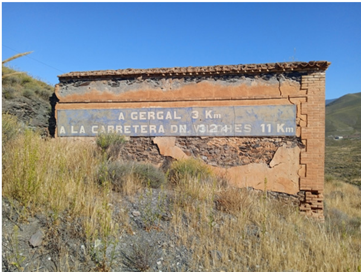
Caseta de los peones camineros en Gérgal con la nomenclatura de la carretera Almería- Vilches (J. M. Galindo López, 2025)
