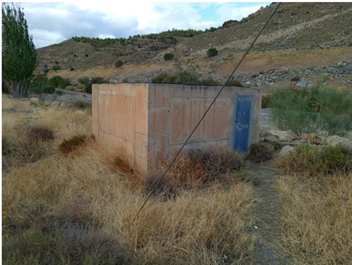
Partidor de Fuente Galindo en la margen derecha del barranco (J. M. Galindo López, 2025)
