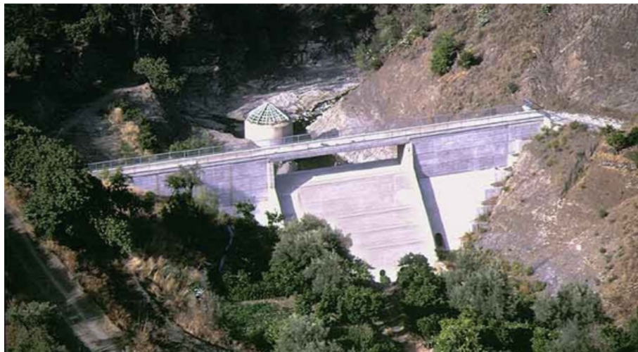
Presa de Almancharres ( iagua.es/data/infraestructuras/presas/almancharres )
