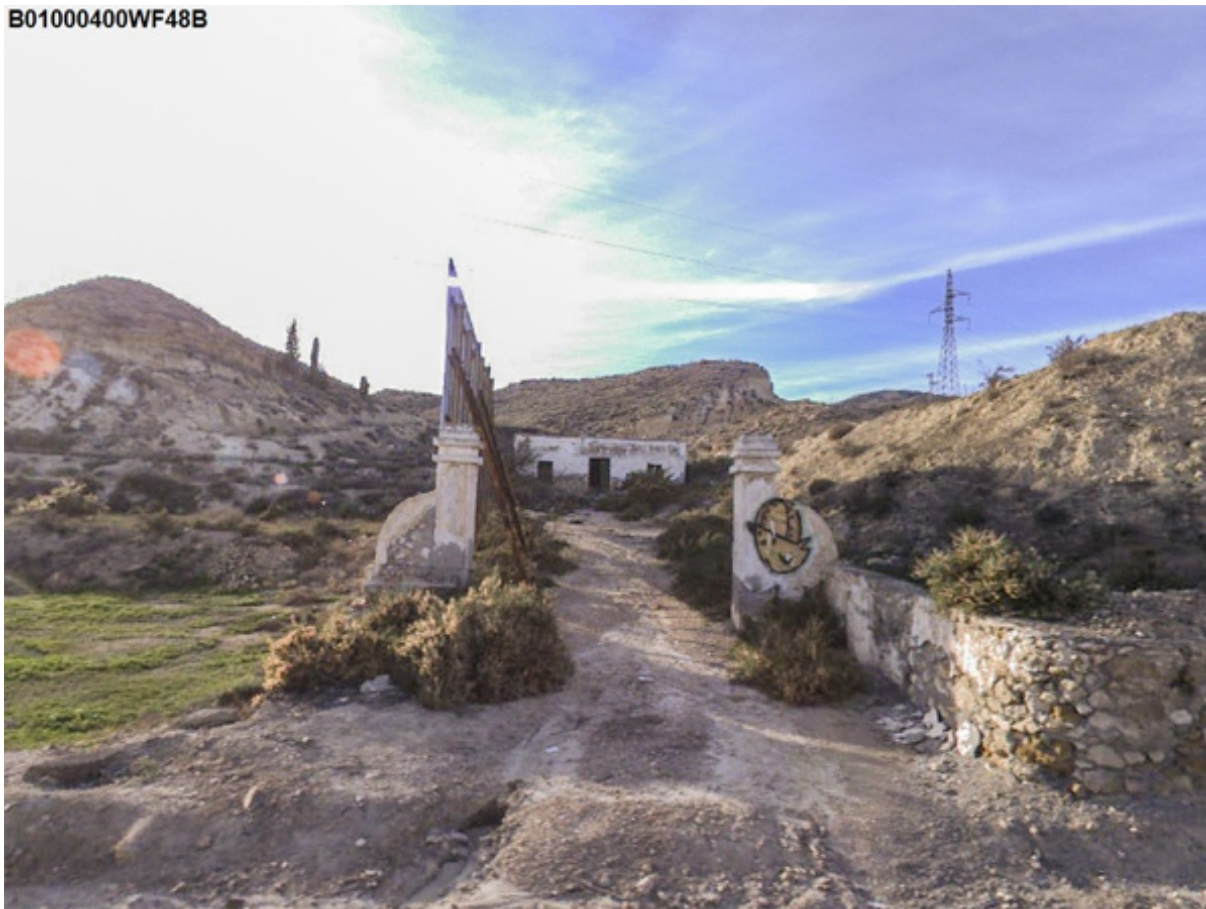
Vista antigua del cortijo antes del derribo de la cancela de acceso a la finca (Foto del Catastro de hace unos años)
