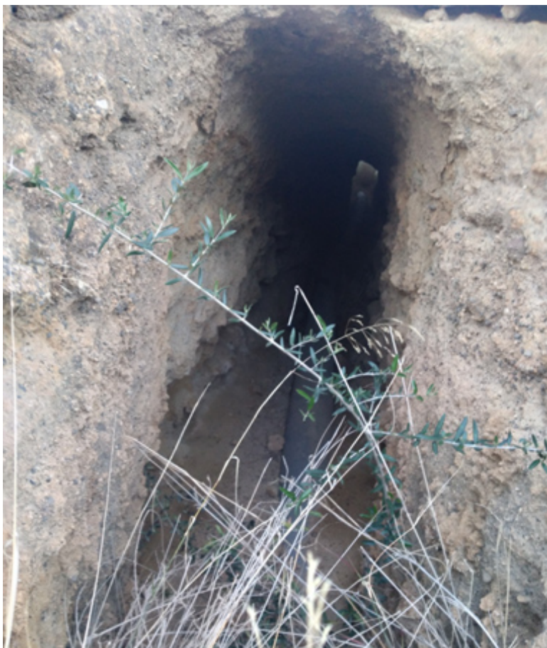
Entrada a la galería que conducía el agua a la balsa. Se ha instalado una tubería plástica (J. M. Galindo López, marzo 2026)
