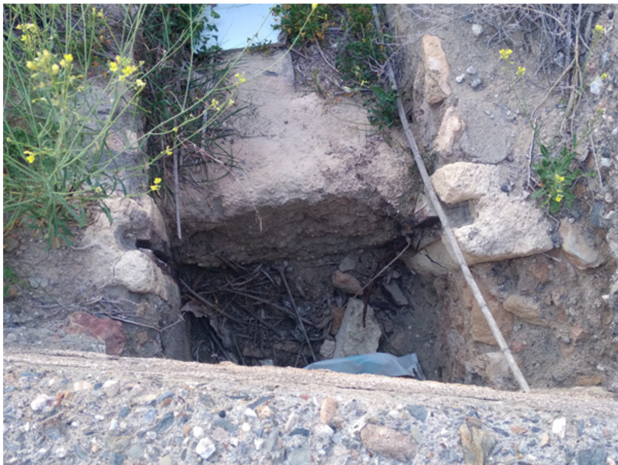
Parada de entrada del agua al depósito (J. M. Galindo López, abril 2026)
