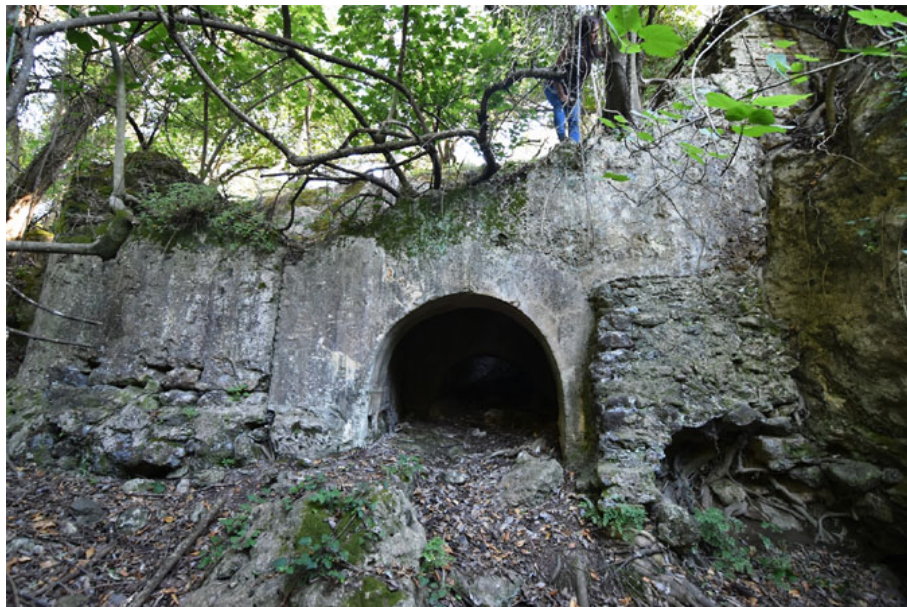
Molino de la ribera del Guadalbaccar, salida de los cárcavos y alzado principal (A. Márquez Pascual, junio 2026)
