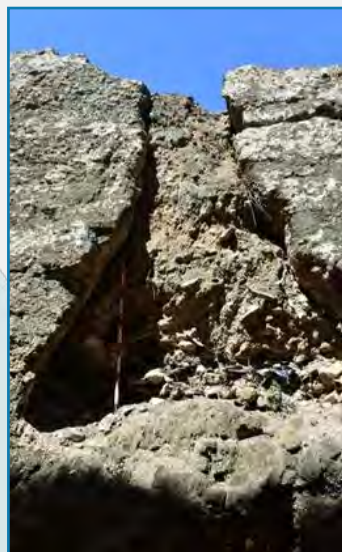
Foto 12. Sección de la cisterna romana 1 rellena por un vertido de escombros (A. Márquez, mayo 2024)
